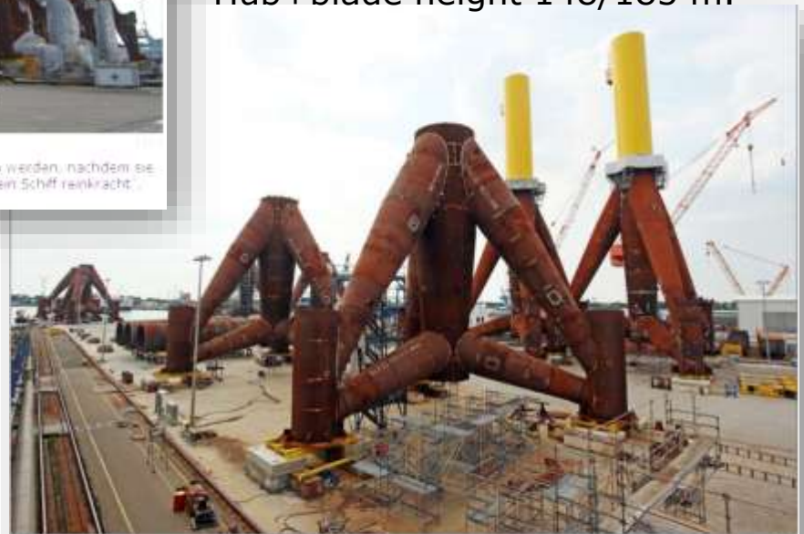
Offshore-Windenergieanlagen im Industriehafen in Emden: Sie sollen auf See gebracht werden.
